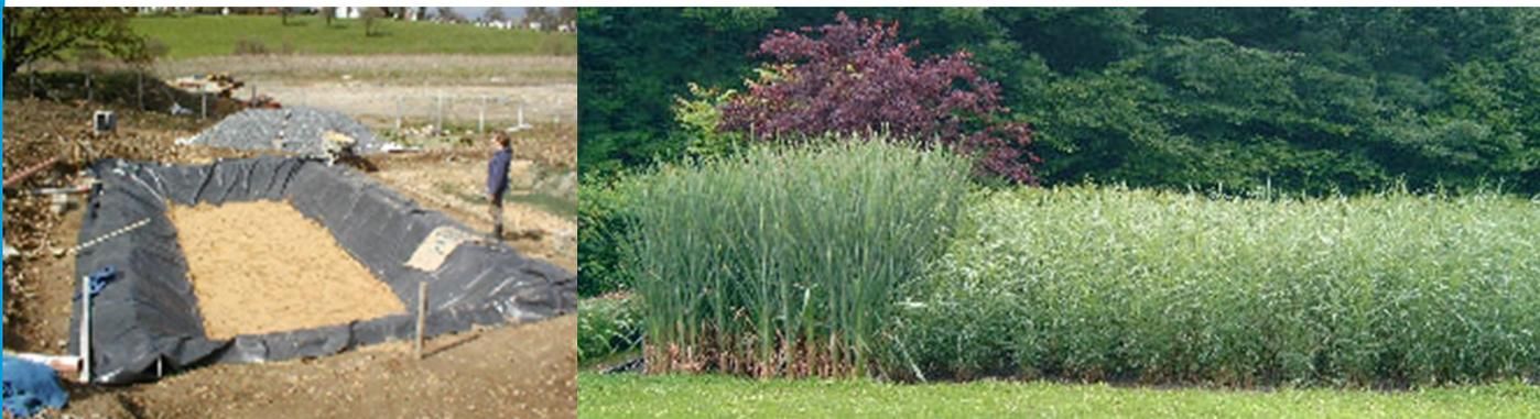
*Installation d'un filtre planté (gauche) et apparence d'un filtre planté en fonctionnement (droite)*
